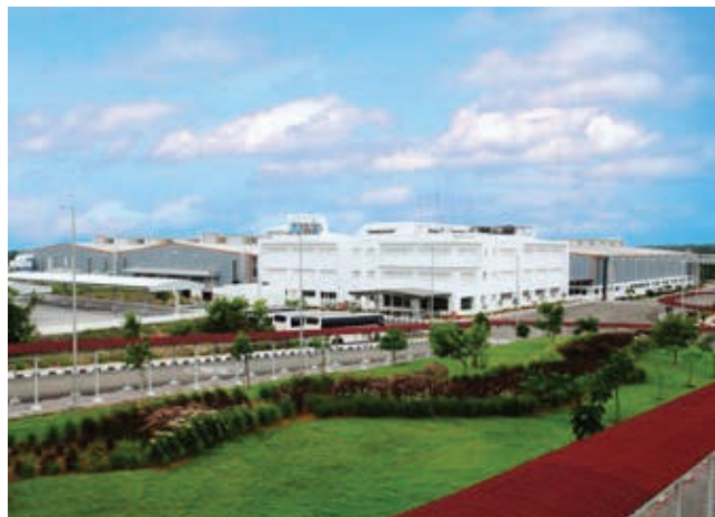
» Air Centre Plant (ACP) je najsuvremeniji proizvodni pogon tvrtke ELGi u Indiji, obuhvaća 32.700 metara kvadratnih proizvodnih površina i rasprostire se po zemljištu veličine 89.000 metara kvadratnih. | Izvor: ELGi Equipments
