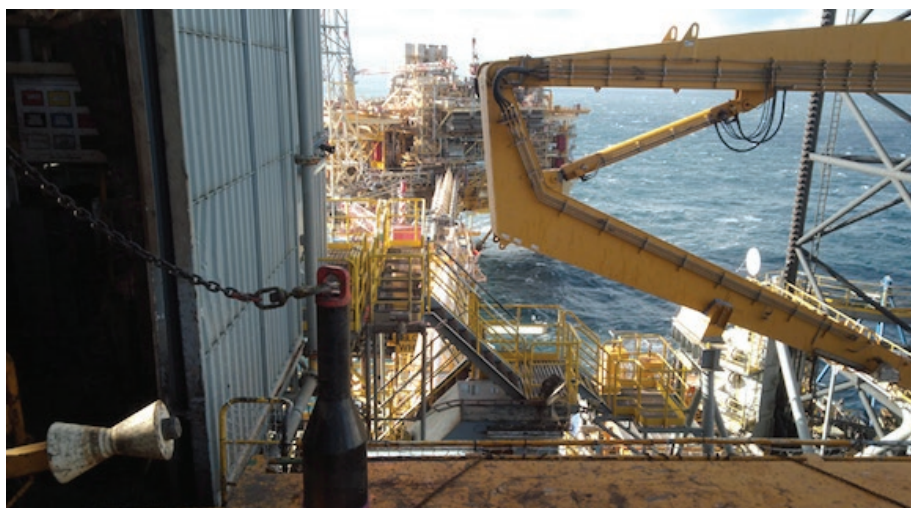
» Vodna puša Vallourec, izdelana s tehnologijo AM, ima polovico teže (220 kg) tiste, ki se proizvaja tradicionalno in je bila uporabljena na ploščadi EIG Elgin-Franklin v Severnem morju.
